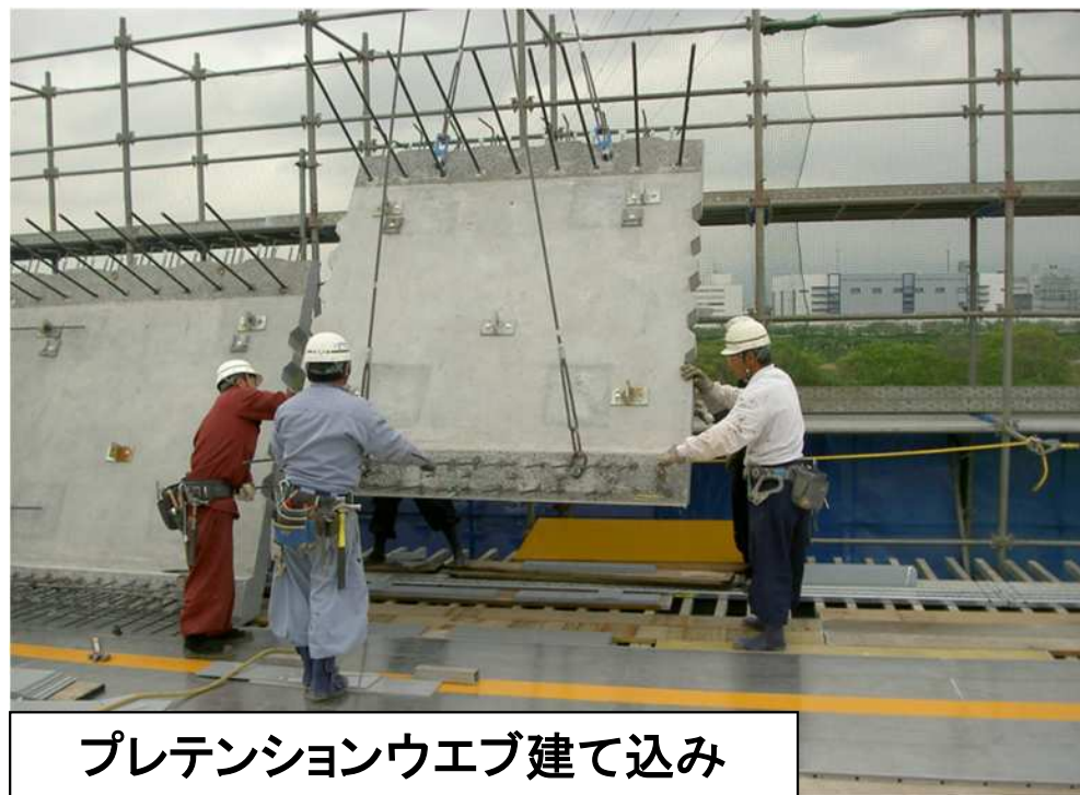
プレテンションウェブ設置完了
