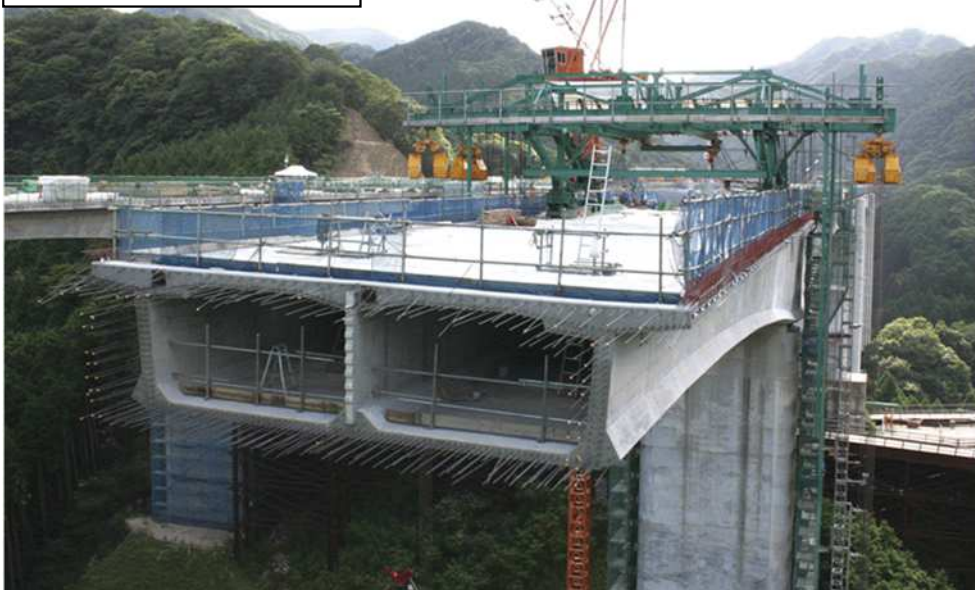
施工状況写真
