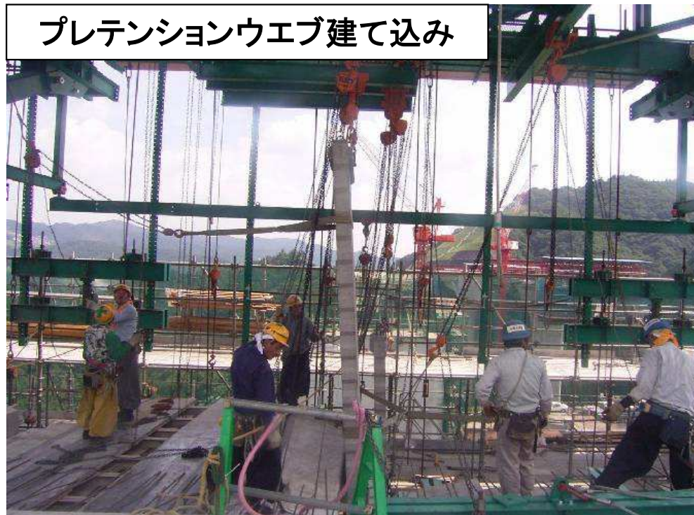
プレテンションウェブ設置完了
