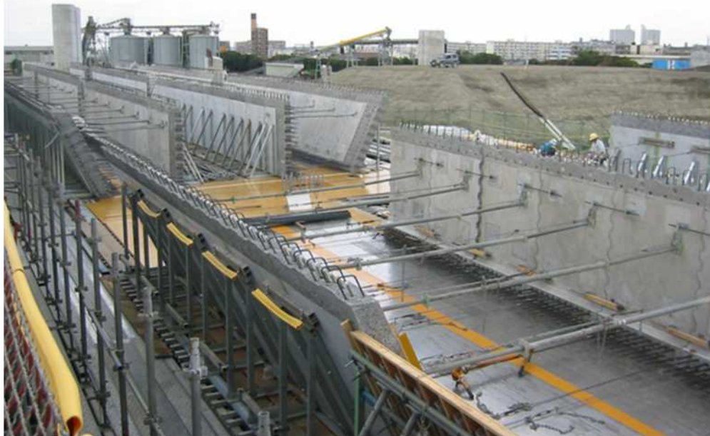
施工状況写真
