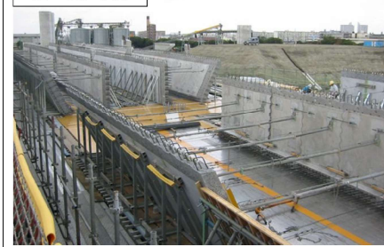
施工状況写真
