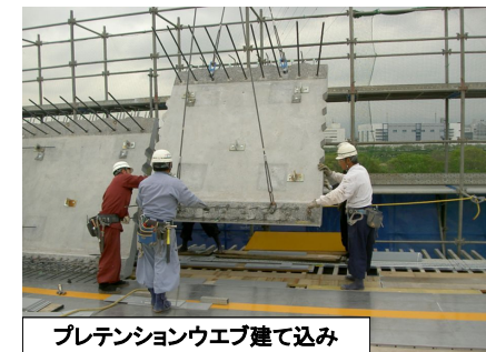
プレテンションウェブ設置完了
