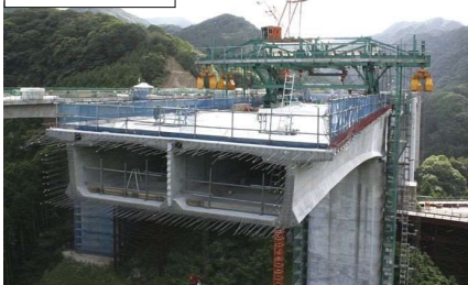
施工状況写真
