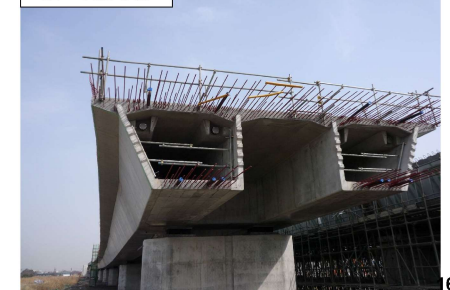
施工状況写真
