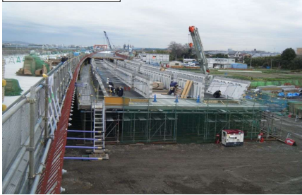
施工状況写真
