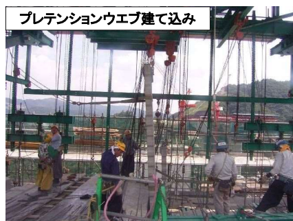
プレテンションウェブ設置完了
